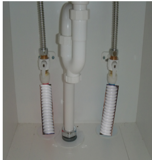
③継手が床下になるので、出来るだけこのような施工はしない。
