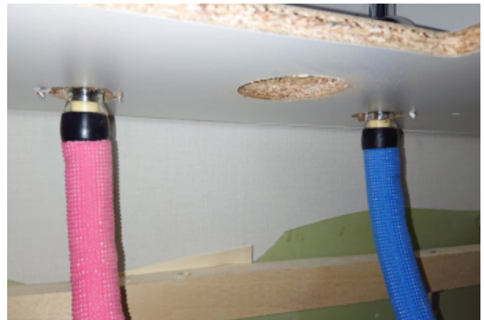
③継手が床下になるので、出来るだけこのような施工はしない。
