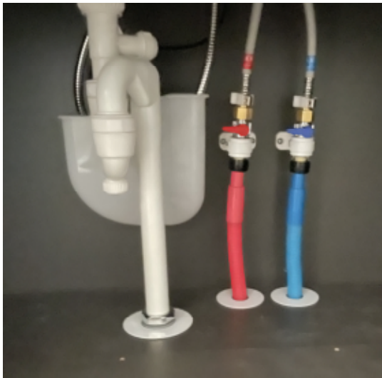
③継手が床下になるので、出来るだけこのような施工はしない。
