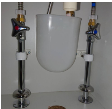
③継手が床下になるので、出来るだけこのような施工はしない。
